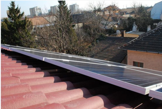
Napelem rendszer szerelés Budapest 5 kW-os rendszer
