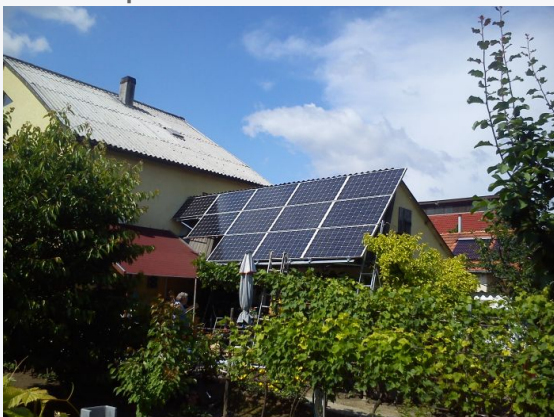
3 kW-os napelem rendszer Tát
